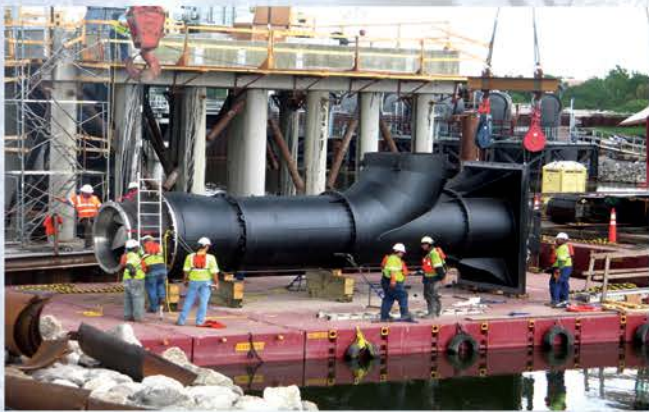
Disponible en configuraciones de eje de línea abierta o cerrada. Los tubos de cierre, cuando se usan, son el horario 80 y están soportados por arañas cuando se requiere por la longitud de la bomba.
