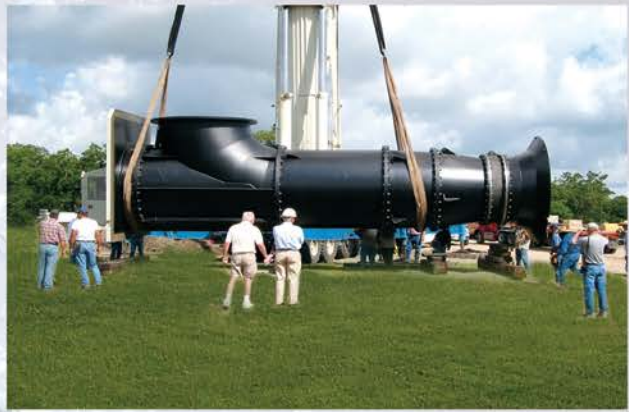
Disponible en configuraciones de eje de línea abierta o cerrada. Los tubos de cierre, cuando se usan, son el horario 80 y están soportados por arañas cuando se requiere por la longitud de la bomba.
