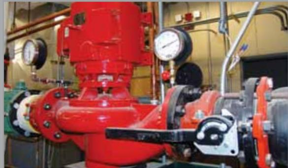
**Edificio Woolworth**—las bombas verticales en línea con acoplamiento cerrado EnviroFlo proporcionan calidad y confiabilidad de clase mundial en la circulación de agua de condensador para 18 unidades de tres pisos de esta estructura de renombre mundial de la ciudad de Nueva York.
